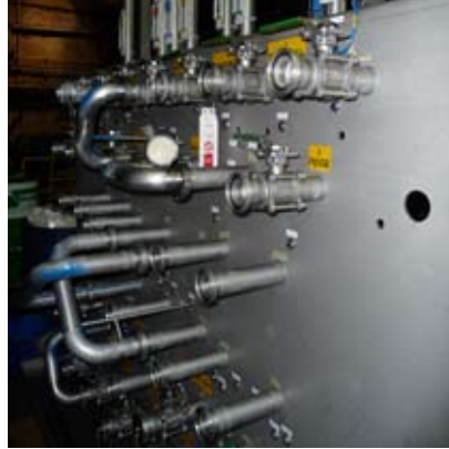
Les vannes failsafe résistent au feu et se referment en cas d'incendie.
